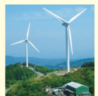
長島風力発電所
