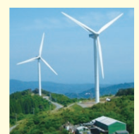
長島風力発電所
