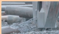
廃コンクリート柱を破砕
