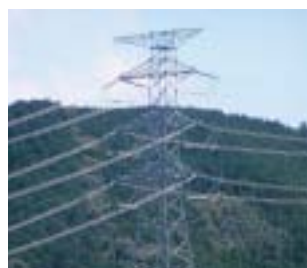
環境塗装をしていない通常の鉄塔
