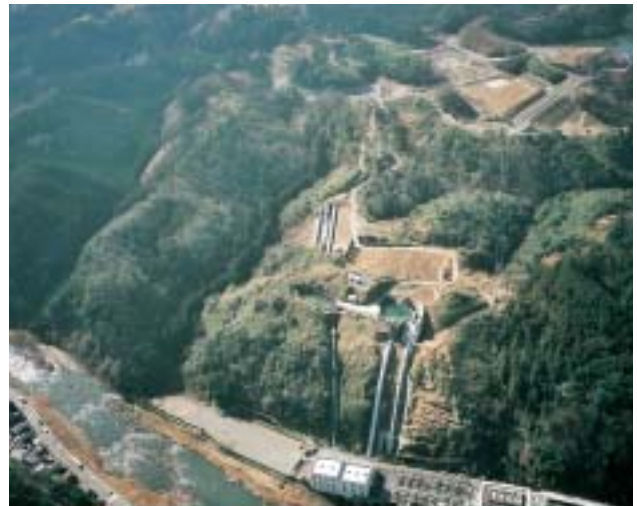
女子畑発電所の全景
