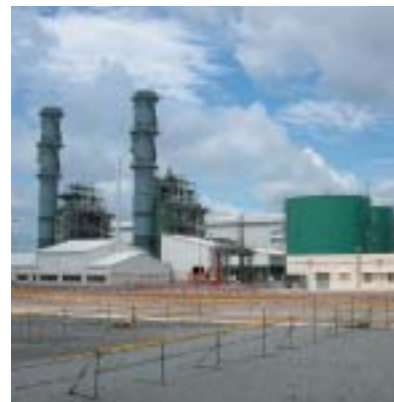
建設中のベトナム・フーミー3号 IPP
