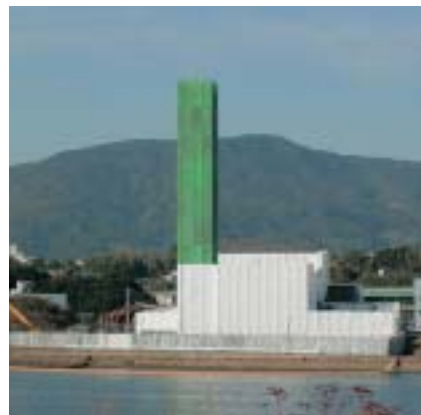
(佐世保市旧東部クリーンセンター施設解体工事)
