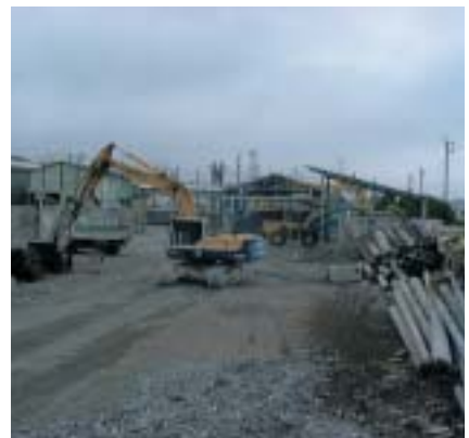
(一次破碎現場の状況)
