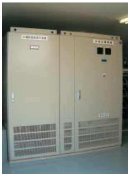
(双方向コンバータ系統連系保護盤)
