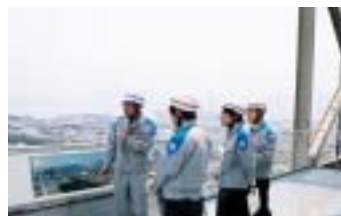
発電所設備に関して技術次長から説明 (新小倉発電所)
