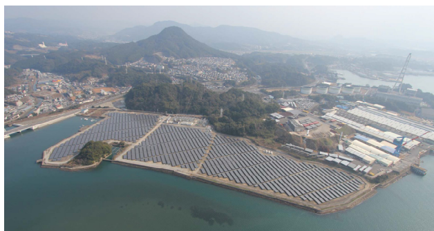
佐世保メガソーラー発電所（グループ会社の九電みらいエナジー株）
