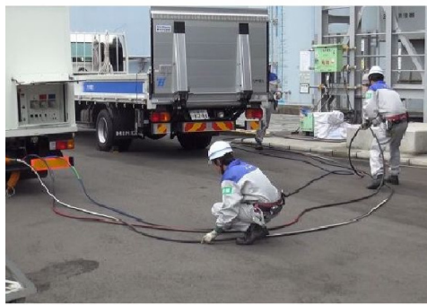
電力の供給訓練
