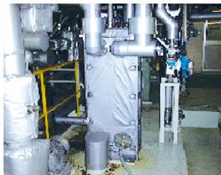
熱交換器保温施工例
