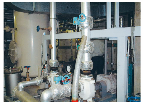
配管保温施工例
