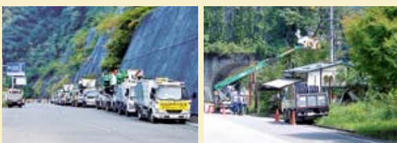
宮崎支店 2005年9月の台風14号による災害復旧工事の様子
