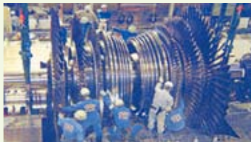
▲川内1号タービン取替の様子
