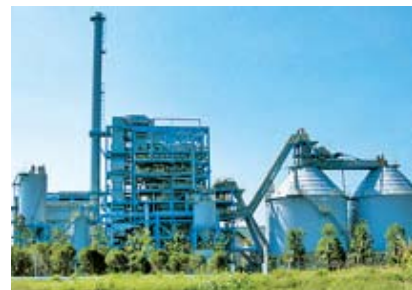
鶏ふん焼却発電施設「みやざきバイオマスリサイクル」
