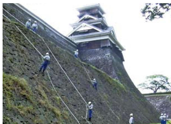
熊本支店 熊本城壁清掃
