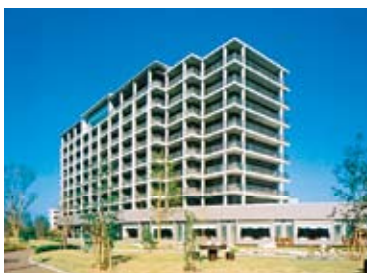
九電ケアタウン(福岡県福津市)
