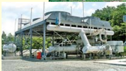
八丁原バイナリー発電所
