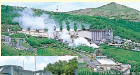
八丁原発電所
