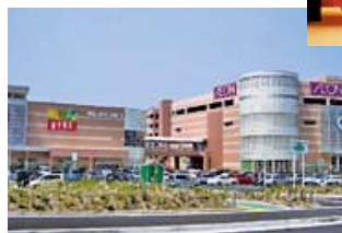
イオン伊都ショッピングセンター (空調管設備)
