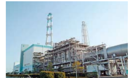
新大分発電所(LNG火力)
