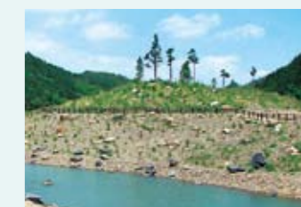
上部調整池周辺緑化状況
