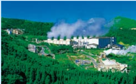
八丁原発電所(大分県九重町 ここのえ )
