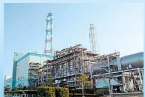
新大分発電所(LNG火力)
