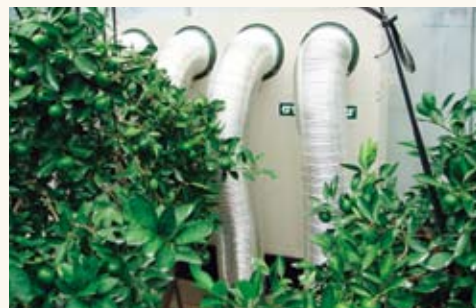
ハウスミカン栽培におけるヒートポンプ設置状況
