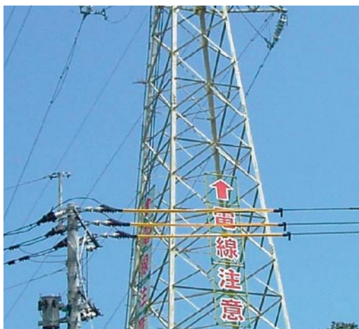
注意喚起標識の設置状況
