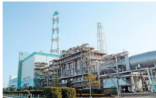
新大分発電所(LNG火力)
