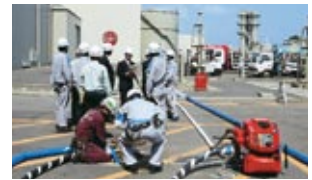
仮設ポンプ設営
