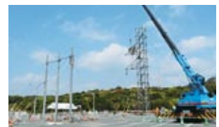
仮鉄柱組立・据付
