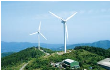
長島風力発電所
