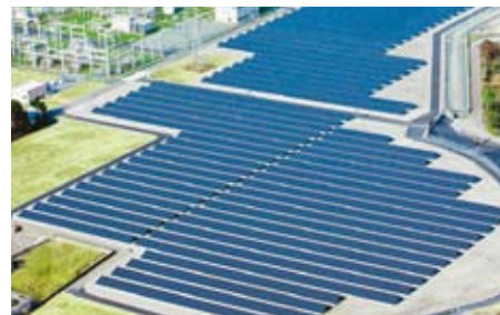
メガソーラー大牟田発電所
