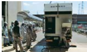
高圧発電機車の繋ぎ込み
