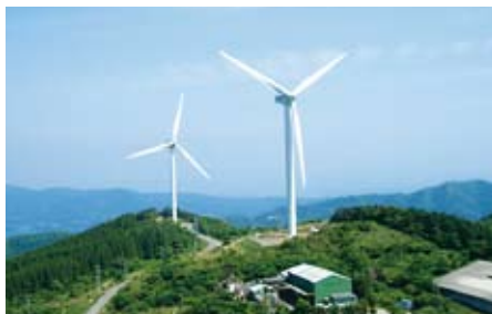
長島風力発電所
