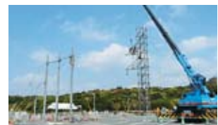
仮鉄柱組立・据付
