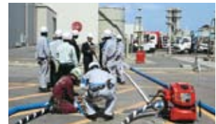
仮設ポンプ設営
