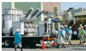
車載型移動用変圧器の接続
