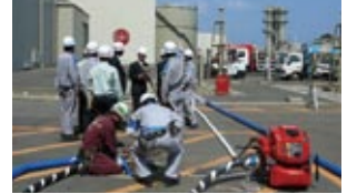
仮設ポンプ設置
