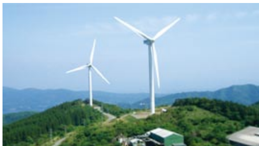
長島風力発電所
