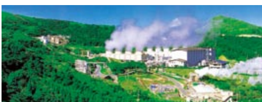
八丁原発電所
