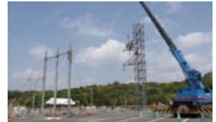
仮鉄柱組立・据付
