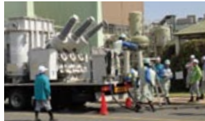
車載型移動用変圧器の接続
