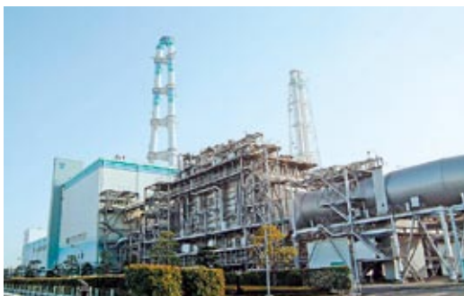
新大分発電所(LNG火力)
