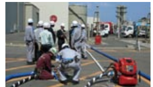
仮設ポンプ設置
