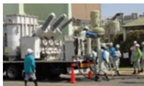
車載型移動用変圧器の接続
