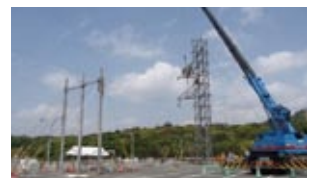
仮鉄柱組立・据付
