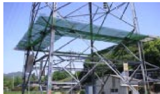
送電鉄塔の昇塔防止装置設置状況
