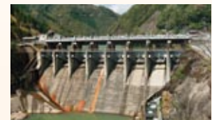
山須原ダム(改造前)
