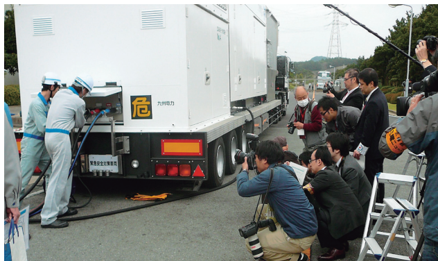
移動式大容量発電機による電源供給訓練公開の様子
