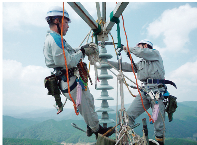
送電線碍子の取替作業
