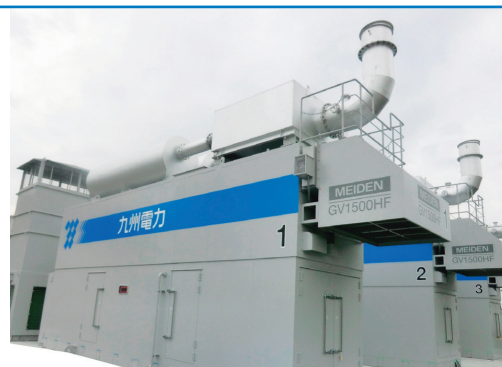
豊前発電所に設置したディーゼル発電機
