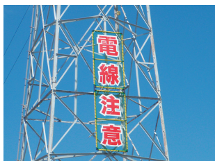
注意喚起標識の設置状況
