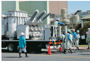
●移動用機器による電力供給訓練
