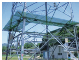
送電鉄塔の昇塔防止装置設置状況
