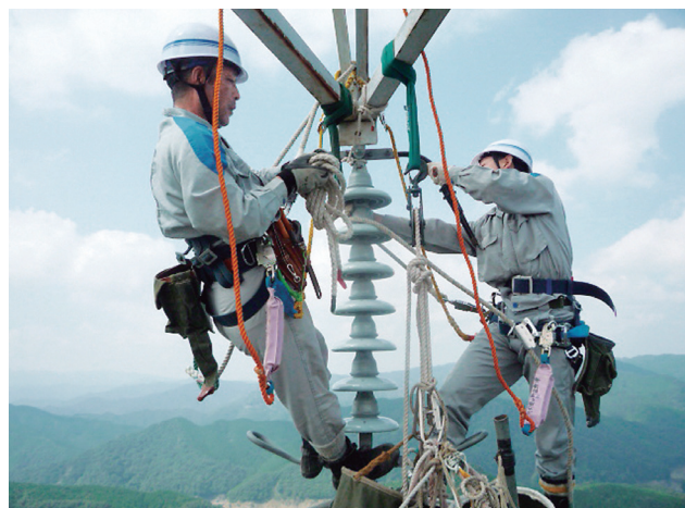
送電線碍子の取替作業
