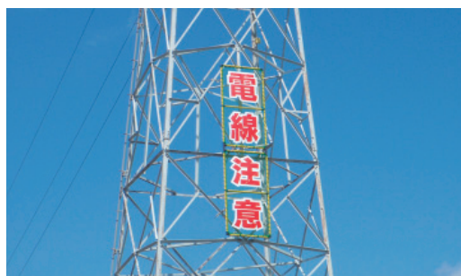
注意喚起標識の設置状況
