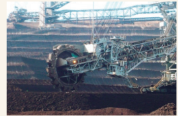
ビクトリア州褐炭採掘現場
