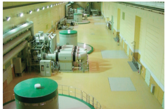
小丸川発電所 (地下発電所)
