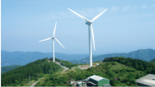
長島風力発電所
