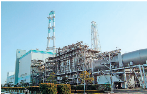
新大分発電所 (LNG火力)
