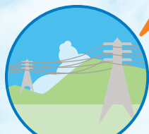
送電線・鉄塔
