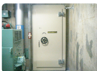
タービン動補助給水ポンプ室の水密扉
