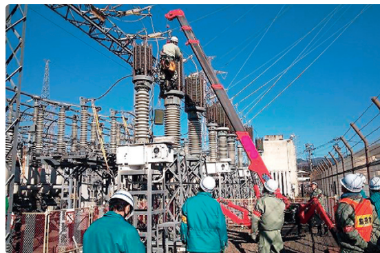
現場作業の安全状況を確認する安全パトロール(人吉変電所)
