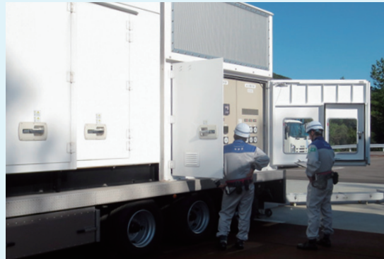
大容量空冷式発電機による電源供給の様子
