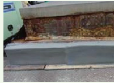
モルタル補修材による仕上がり状況【補修後】
