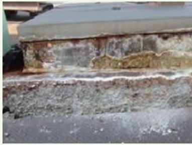
コンクリート構造物の酸性劣化状況【補修前】
