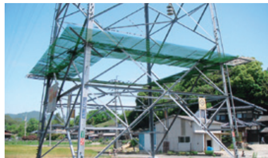
送電鉄塔の昇塔防止装置設置状況
