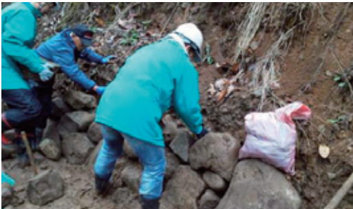
棚田の石積み復旧作業
