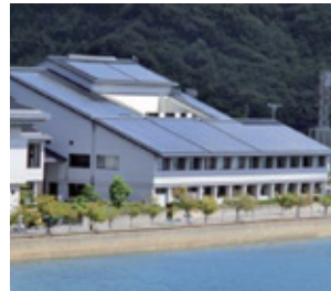
太陽光パネル(屋根設置)
