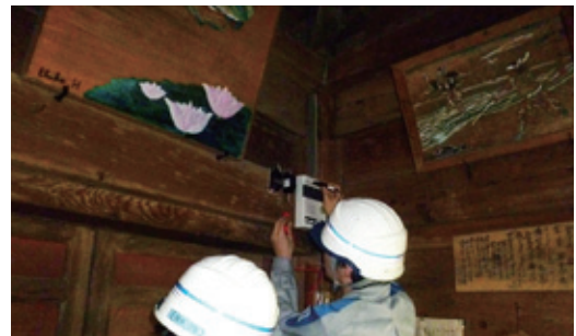
重要文化財配線診断(人吉営業所)
