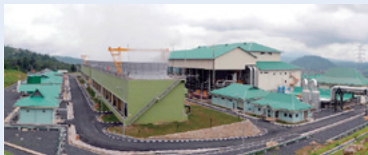
ウルブル地熱発電所(インドネシア)
