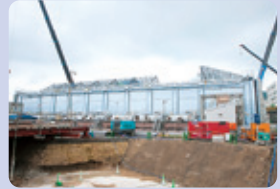
新設された防護壁
