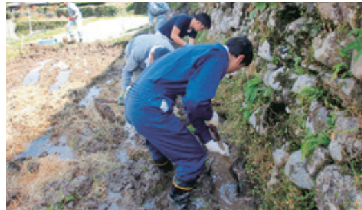
棚田の畦及び水路の復旧作業
