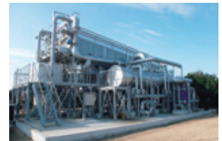
山川バイナリー発電設備
