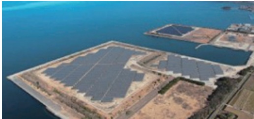
大村メガソーラー発電所
