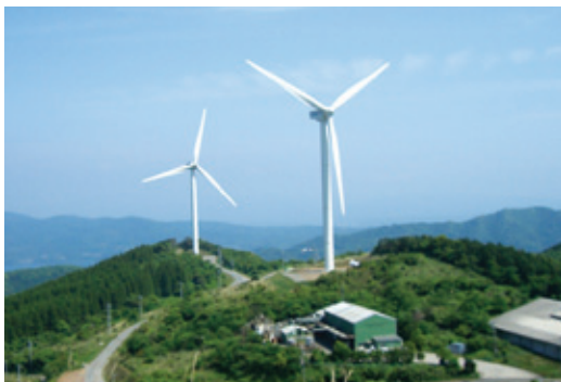
長島風力発電所
