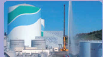
放水砲による放水試験
