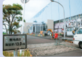
海拔13mのタービン建屋
