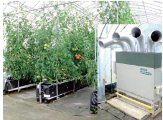
ヒートポンプ利用栽培(トマト栽培状況)
