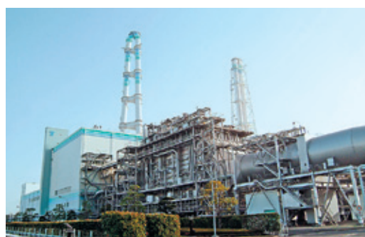
新大分発電所(LNG火力)
