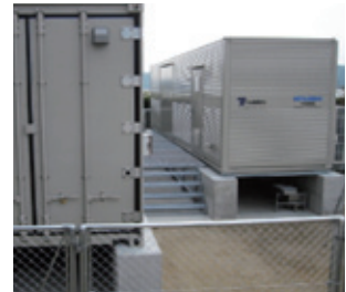
受電設備・蓄電池等収納コンテナ
