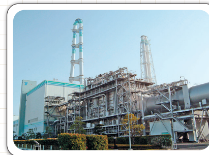
新大分発電所
