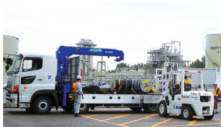
電源ケーブルの運搬
