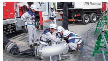
ホースの敷設
