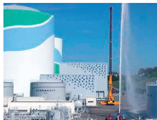
放水砲による放水
