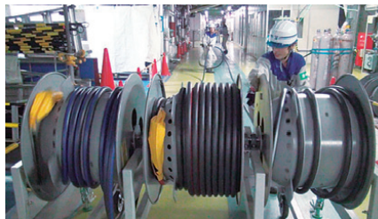
電源ケーブルの敷設(屋内)
