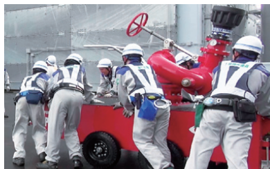
放水砲の設置
