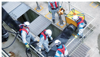
海水を取水する水中ポンプの設置
