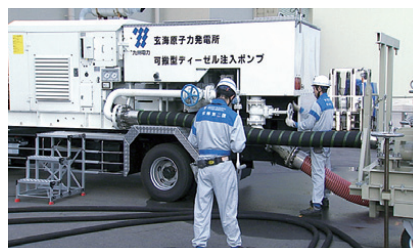
冷却水の供給訓練
