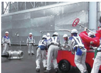
◇放水砲の設置
