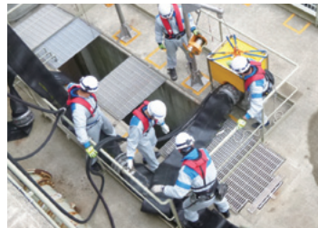
◇海水を取水する水中ポンプの設置
