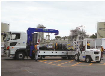
◇電源ケーブルの運搬
