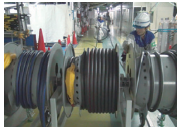
◇電源ケーブルの敷設(屋内)
