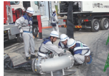
◇ホースの敷設
