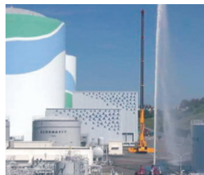
◇放水砲による放水
