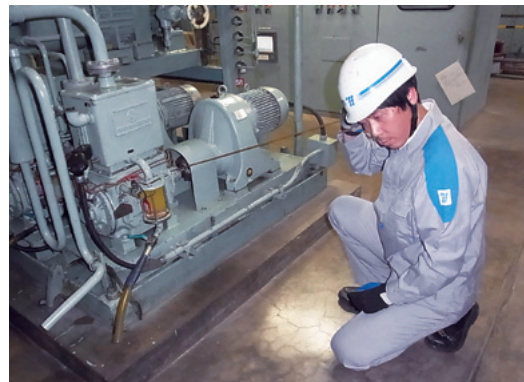
設備異常の早期発見パトロール(聴診棒による異音の確認)
