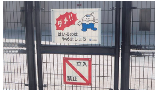
変電所の注意喚起標識設置状況
