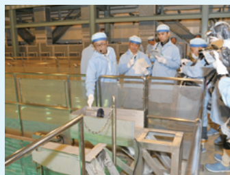
使用済燃料ピット水位計の設置状況
