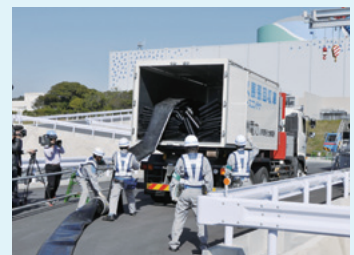
給水訓練の実施状況(冷却水送水ホースの敷設)
