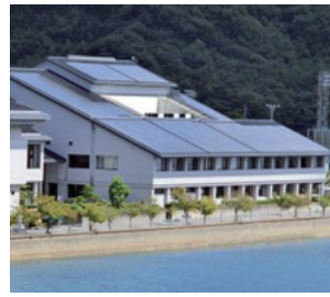
太陽光パネル(屋根設置)
