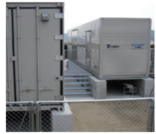
受電設備・蓄電池等収納コンテナ
