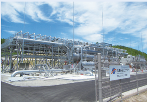
発電設備の外観
