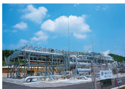
菅原バイナリー発電所
