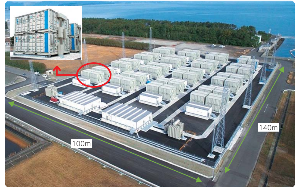
豊前蓄電池変電所(福岡県豊前市) NAS電池®(ナトリウム・硫黄電池)コンテナ252台
