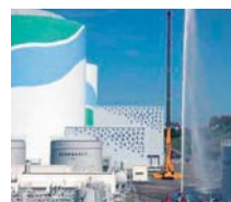
放水砲による放水訓練
