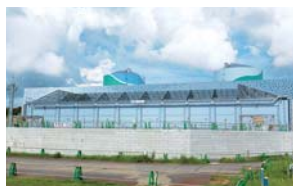
海水ポンプエリア周辺の防護壁
