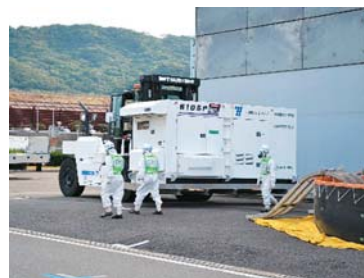
電源供給訓練 (可搬型電源の設置)
