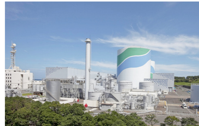
川内原子力発電所
