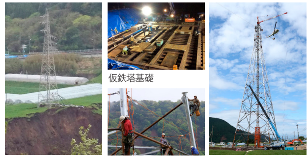
鉄塔被害状況
