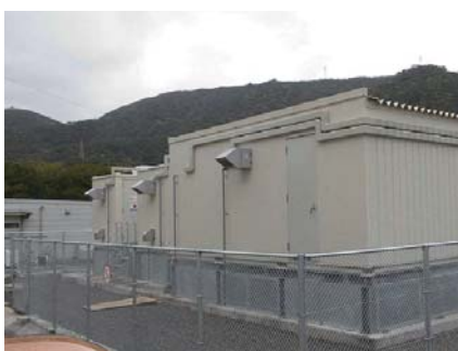
奄美大島の実証試験設備(鹿児島県)
