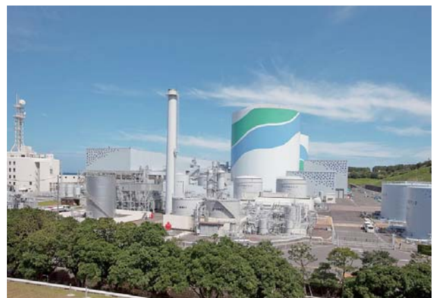
川内原子力発電所
