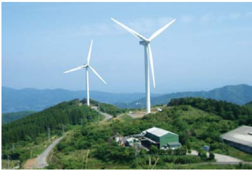
長島風力発電所
