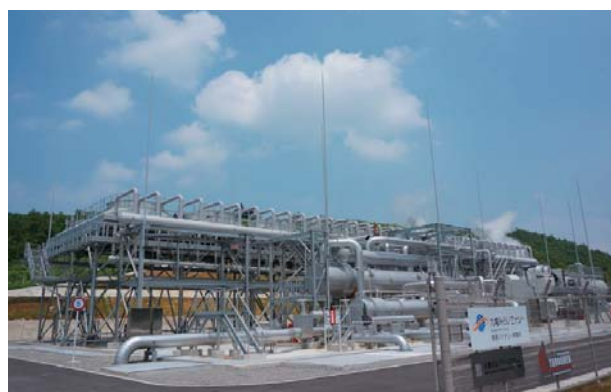
菅原バイナリー発電所
