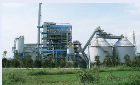
みやざきバイオマスリサイクル発電所
