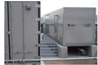
受電設備・蓄電池等収納コンテナ
