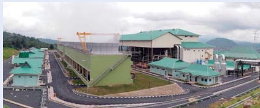
ウルブル地熱発電所(インドネシア)
