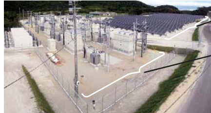
【太陽光パネル】
