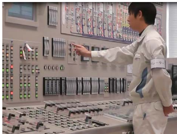
中央制御室の遠隔操作で棧橋とLNG船をつなぐロープを切り離す様子
