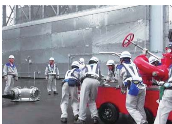
◇放水砲の設置
