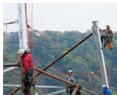
「平成28年熊本地震」 における仮鉄塔建設作業
