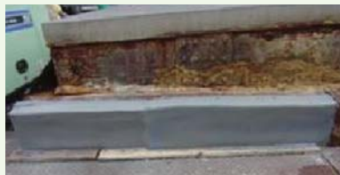
モルタル補修材による仕上げり状況【補修後】
