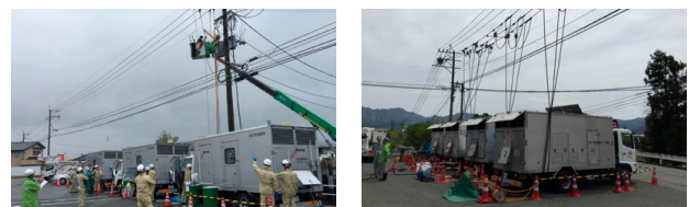
高圧発電機車による送電
