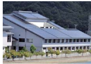
太陽光パネル(屋根設置)
