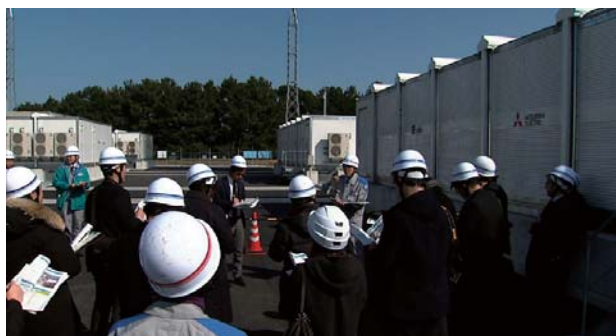
豊前蓄電池発電所の現場公開
