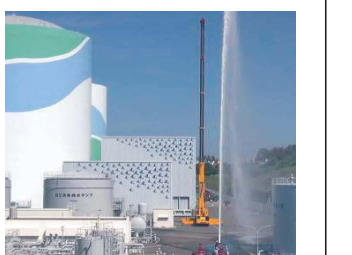
◇放水砲による放水
