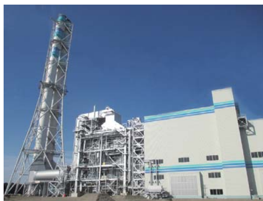
新大分発電所3号系列第4軸(LNG火力)
