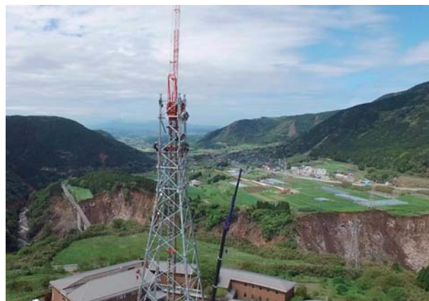
熊本地震復旧作業(仮送電線ルート建設工事)
