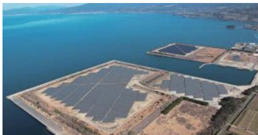
大村メガソーラー発電所
