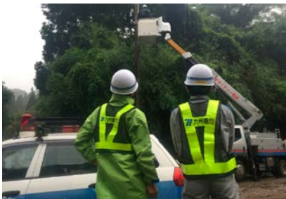
九州北部豪雨復旧作業
