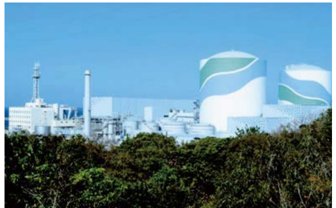
川内原子力発電所
