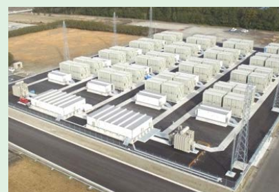
蓄電池システムを活用した再生可能エネルギーの受入れ (豊前蓄電池変電所)
