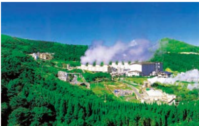
八丁原発電所
