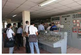
ウズベキスタン・地域エネルギー供給調査 (現地設備の調査)
