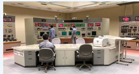
玄海原子力発電所訓練センターシミュレータ室
