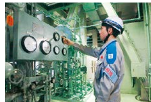
指差呼称による計器の確認
