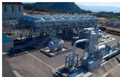
山川バイナリー発電所
