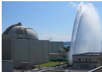
◇放水砲による放水
