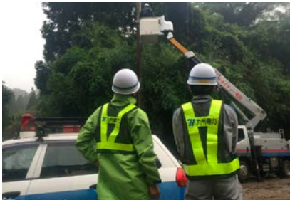
九州北部豪雨復旧作業
