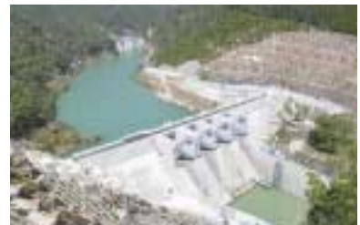
下部ダムの試験湛水状況
