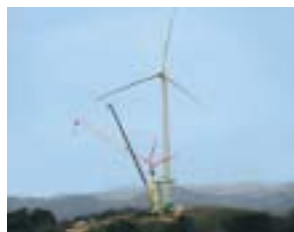
肥前風力発電所の建設風景 (ハブ(支持塔部分)高さ約65m ローター(羽根部分)直径約71m)
