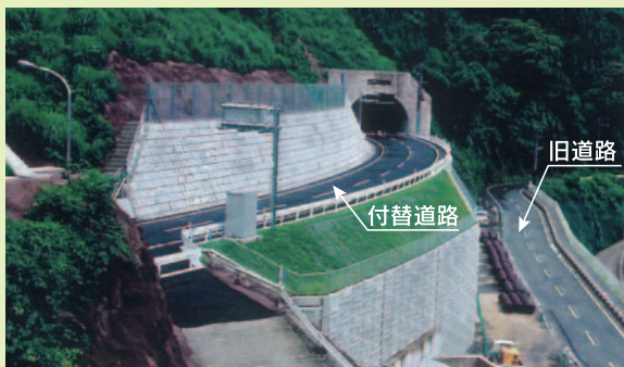
下部ダムに水を貯めると県道が浸かってしまうことから、県道を新たに設置しました。
