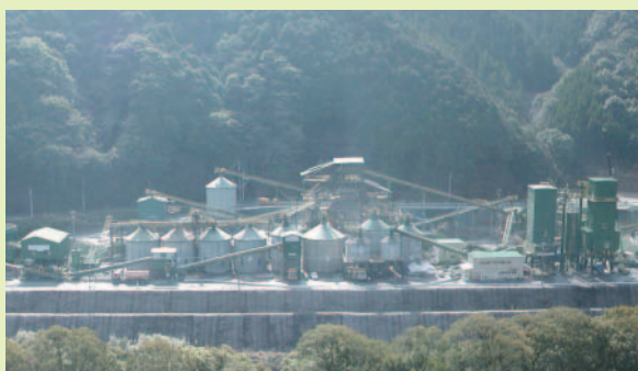
コンクリートの製造が完了し、設備の撤去を行っています。
